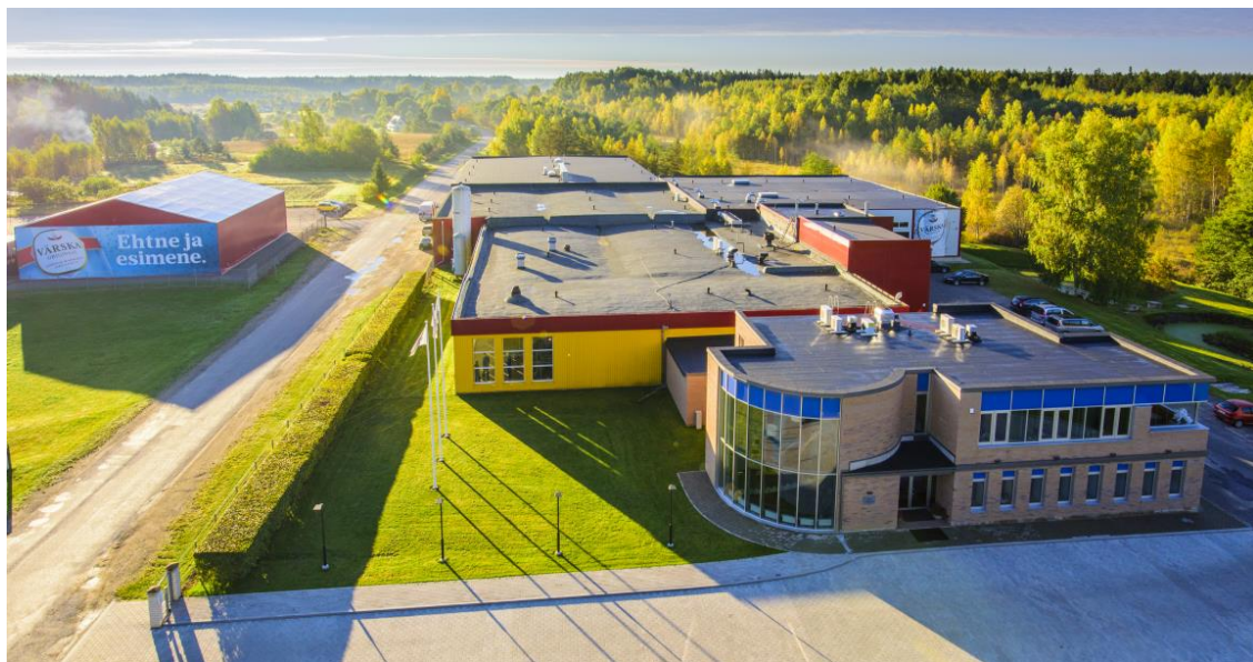
Värskas Vesi AS tootmiskompleks Värskas
